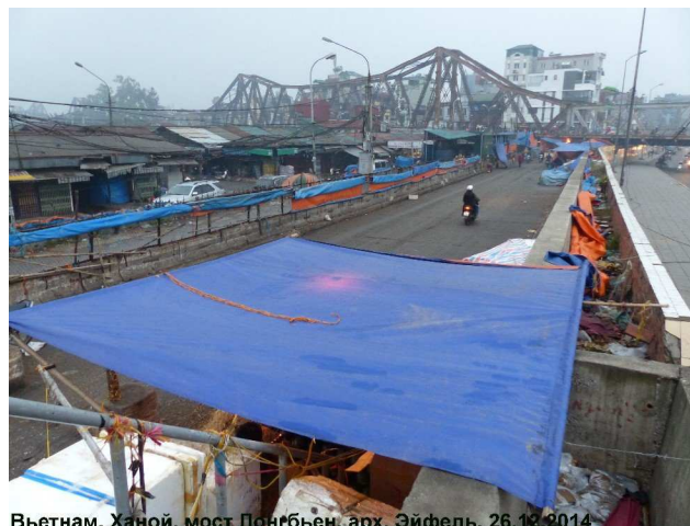
Вьетнам, Ханой, мост Понгбьен, арх. Эйфель, 26.12.2014
